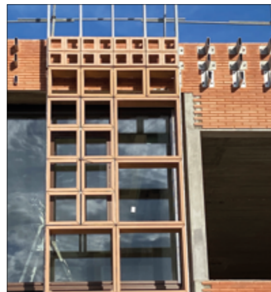
Devant les voiles de béton banché, parés de plaquettes de brique munies de platines de fixation, ont été enfilés les trois types de claustras carrés en terre cuite, sur deux montants acier placés à leurs extrémités.
